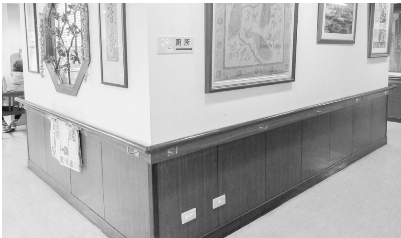
牆壁加裝扶手，使長者走動時更加安全
